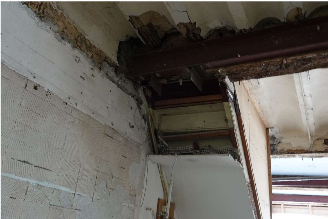
Foto 4. Stalen versteviging van bestaande constructie.
