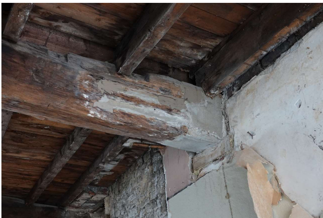
Foto 16. Moerbalk voorzien van nieuwe met kunsthars aangegoten muuroplegging.
