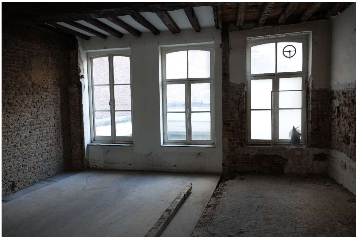
Foto 11. Binnenzijde achtergevel 2 e verdieping.
