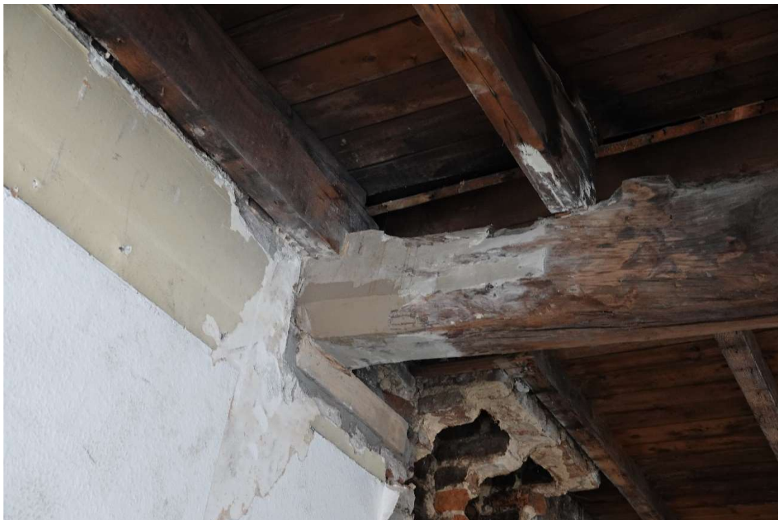
Foto 15. Moerbalk voorzien van nieuwe met kunsthars aangegoten muuroplegging.
