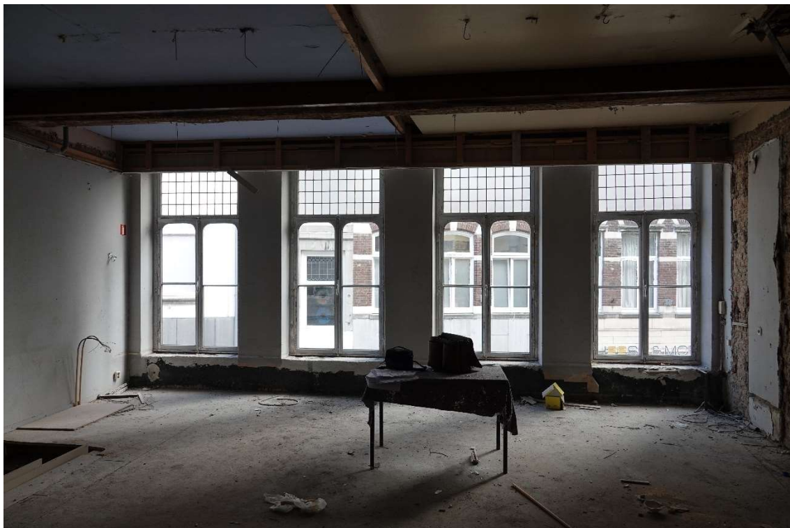
Foto 5. Binnenzijde voorgevel 1 e verdieping.
