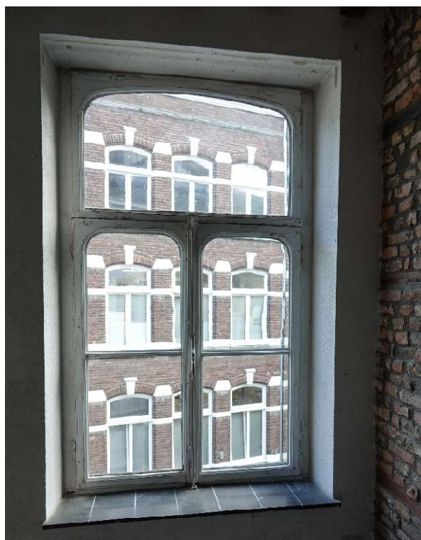
Foto 8. Binnenzijde voorgevel 2 e verdieping.
