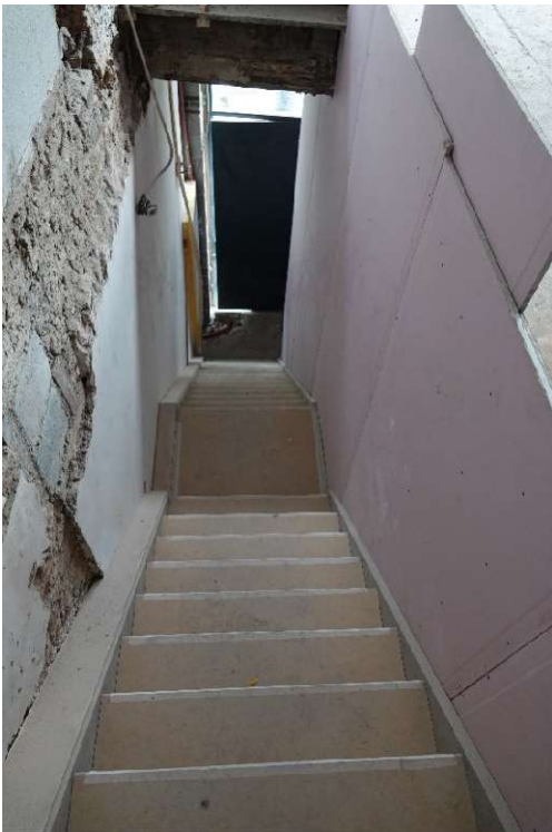
Foto 2. Foto van de reeds gerealiseerde trap, aan linkerkzijde van de foto is de dichtgezette oplegging te zien.
