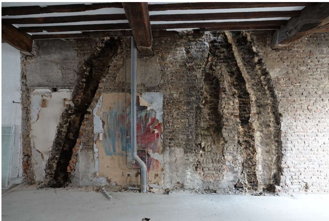
Foto 10. Restant van recent gesloopte schoorsteen en rookgaskanalen op de 2 e verdieping
