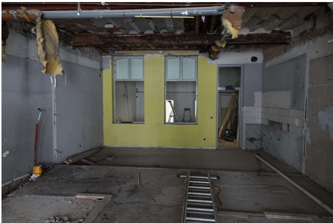
Foto 6. Binnenzijde originele achtergevel 1 e verdieping.
